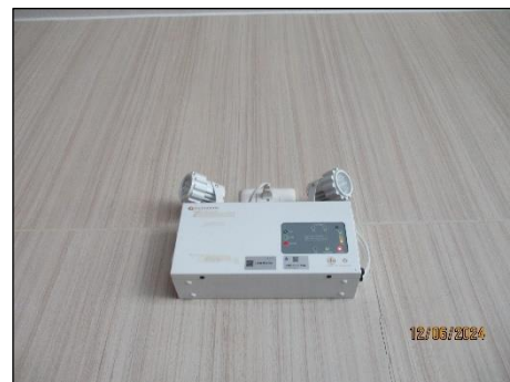
รูปที่ 2-58 ระบบไฟแสงสว่างฉุกเฉินแบบใช้แบตเตอรี่
