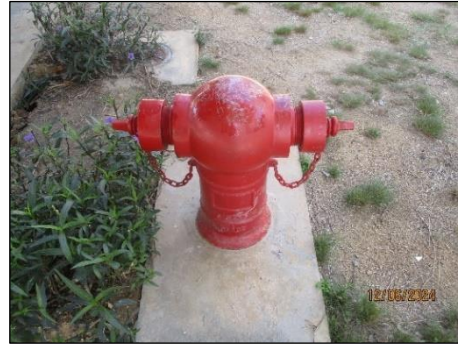
รูปที่ 2-62 หัวรับน้ำดับเพลิงภายนอกอาคาร
